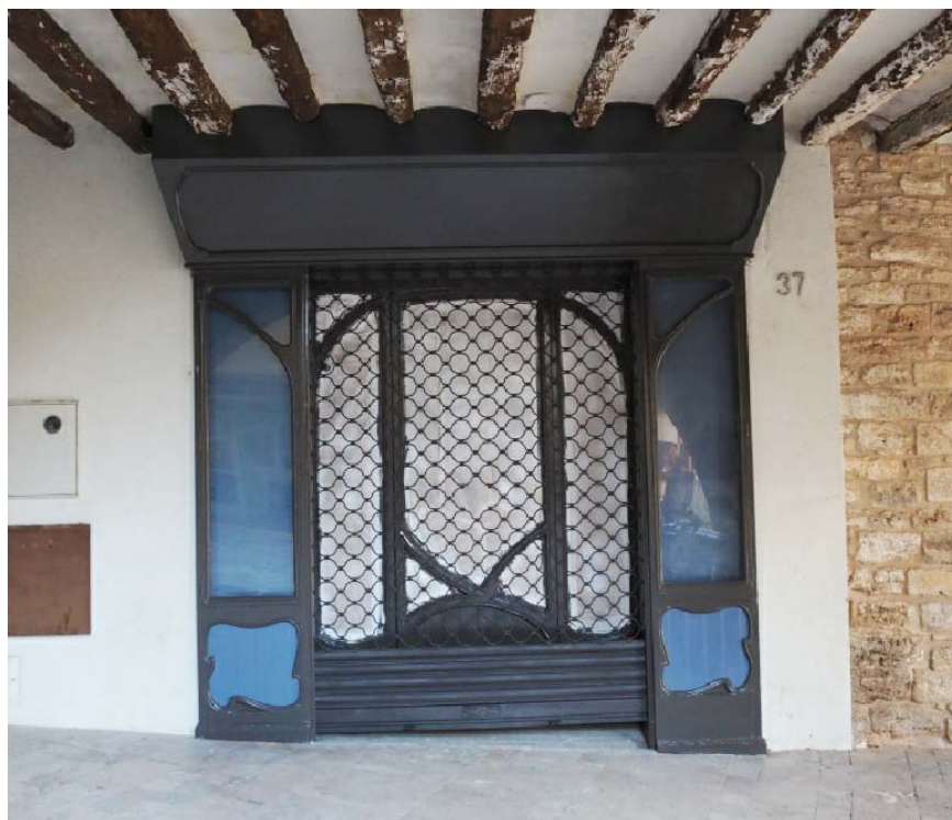
APARADOR DES DE L'EXTERIOR - ESTAT ACTUAL
